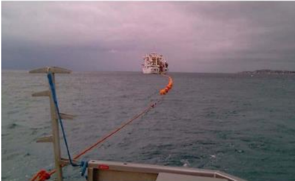
Figure 26 : Exemple de tirage d'un câble depuis un navire câblé vers la plage (source : Orange Marine)
