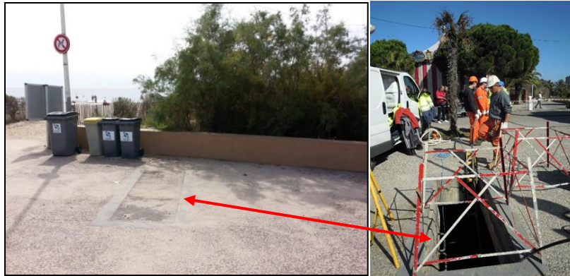
Figure 13 : Vues extérieures d'une chambre-plage : fermée et ouverte (setec in vivo)
