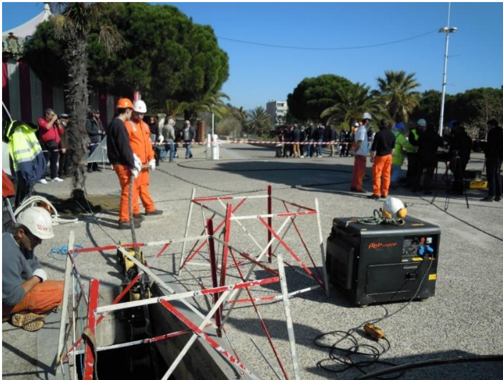
Figure 31 : Tirage du câble en dehors de la chambre plage avant raccordement
