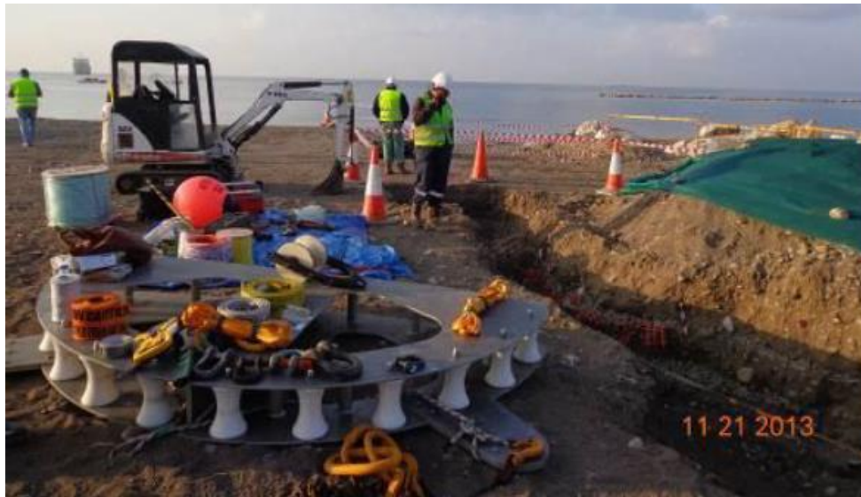
Figure 28 : Vue d'un quadrant (source : Orange Marine)
