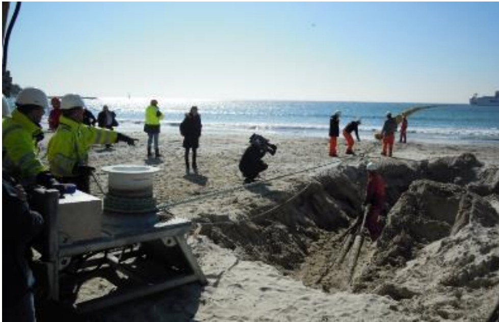
Figure 30: Opération de tirage du câble à terre avec un cabestan hydraulique (source : Orange marine)
